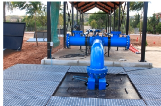
Figura 42. a) Turbogenerador. b) grupo electrobomba (Serie hidrogeología hoy, 2010).
