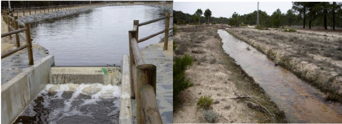
Figura 32. a) Balsa de decantación y represa en Gomezserracín. b) Canal de recarga artificial. (Serie hidrogeología hoy, 2010).
