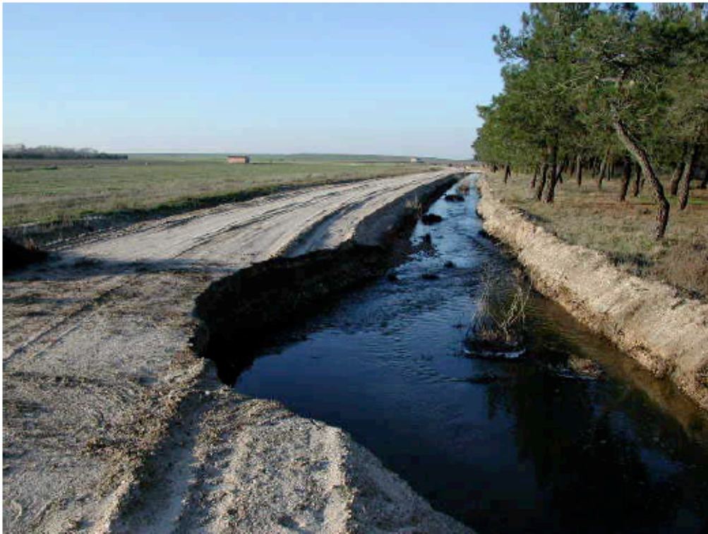
Figura 30. Caz de recarga artificial en la cubeta de Santiuste (Fdez. Escalante, 2005)
