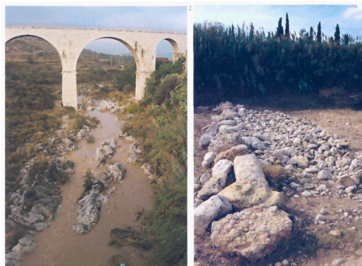
Figura 41. a) Río Gorgos. b) Zanjas filtrantes en el cauce del río Gorgos (IGME, 2000).
