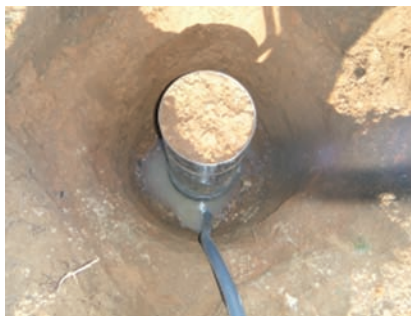
Instalación de lisímetro en Filtro Verde Intensivo.
