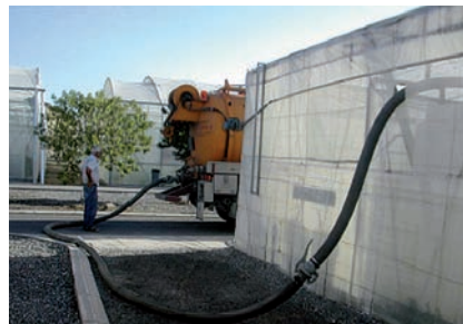
Llenado de depósito de agua residual depurada.
