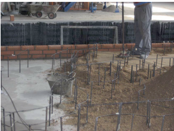
Relleno de topografía con arena
