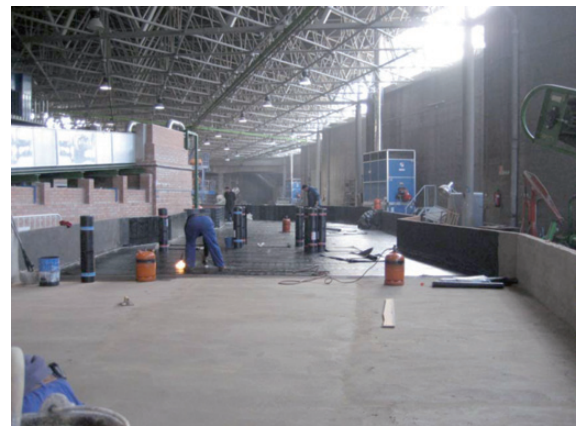
Impermeabilización interior mediante tela asfáltica
