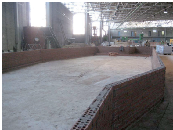
Construcción de muros perimetrales
