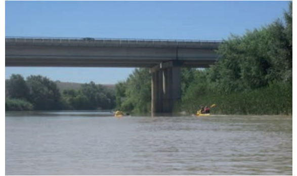
Figura 17. Fotografía del puente de la zona de estudio
