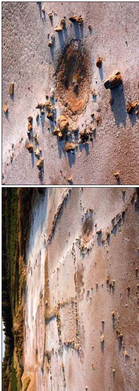
*Figura 4. Detalle del estado de deterioro de las piletas y pozos de la Salinas de Jaraguas.*
