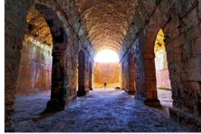
Cisterna romana en Aptera, Creta, Grecia, s I dC
