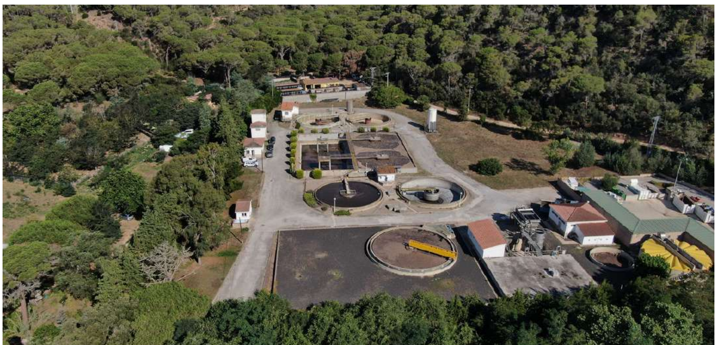
Figura 4.1_4 Planta depuradora de Tossa de Mar (Fuente: CCB)
