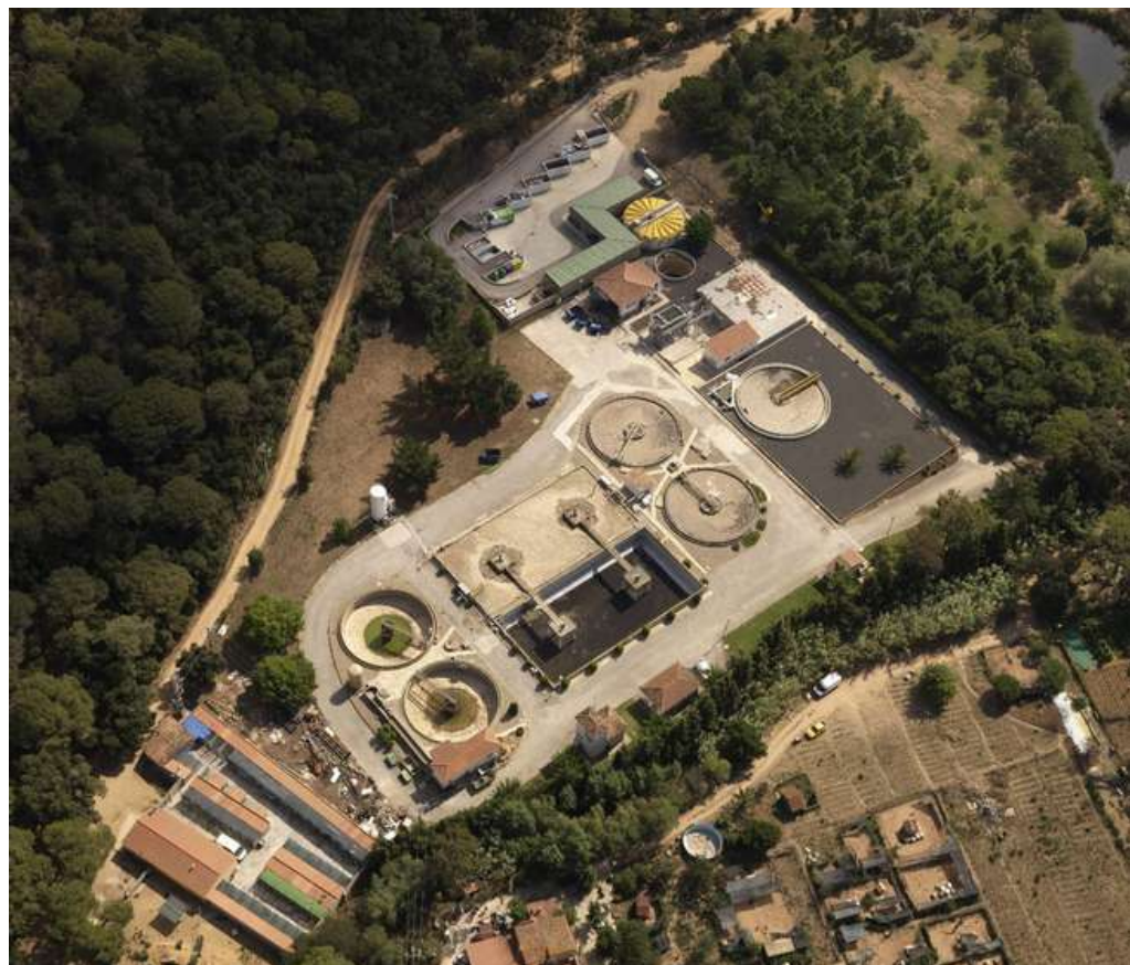
Figura 4.1_1 Planta depuradora de Tossa de Mar (Fuente: CCB)
