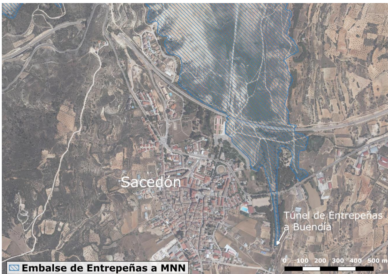
Figura 65. Vista aérea de Sacedón (ortofoto PNOA 2017), con superposición (líneas azules) de la lámina de agua am MNN (cota 718) y señalizada la entrada al túnel de Entrepeñas a Buendía.
